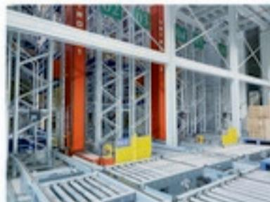
智能化固体制剂工厂立体仓库分为 2 个独立库区,一个为 3 巷道的常温库区,共 3600 个货位;另一个为 2 巷道的阴凉库,共 2400 个货位,共计 6000 个托盘位。货架设计为 10 层,每层货架高 1650mm。为满足出入库峰值流量 300 托/天需求,配套 5 台堆垛机完成原辅料、包材及成品的出入库作业。立体仓库的实施运行,同时借助堆垛机及托盘输送机,实现了货物迅速存取、高效精准出入库管控,提高了企业的效率,实现了高度信息化,同
